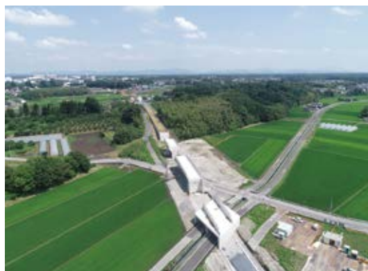
LRT工事 仮称下竹下停留所付近
