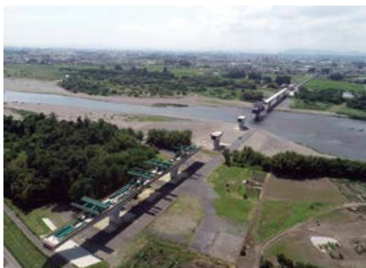
LRT 鬼怒川左岸寄り橋梁工事風景
